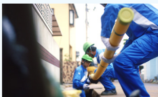
PE管への入替工事
